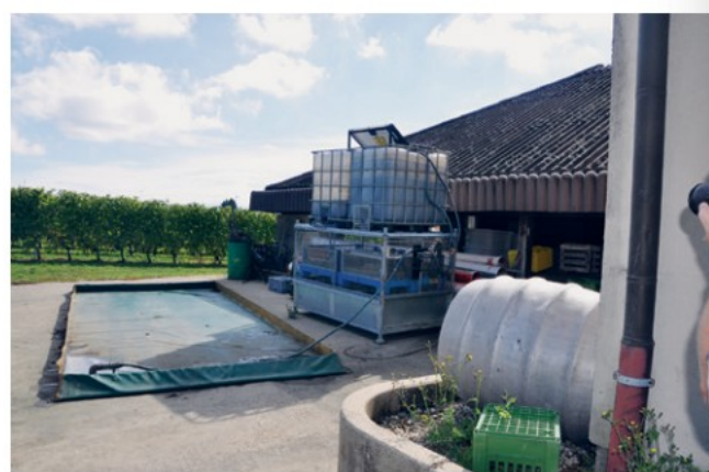
Aire de nettoyage mobile: L'eau de nettoyage est pompée en continu dans la cuve de rétention lors du nettoyage. A cause de l'absence de toit, la bâche doit être rangée après chaque utilisation pour éviter un débordement en cas de fortes précipitations, M. Hochstrasser.
