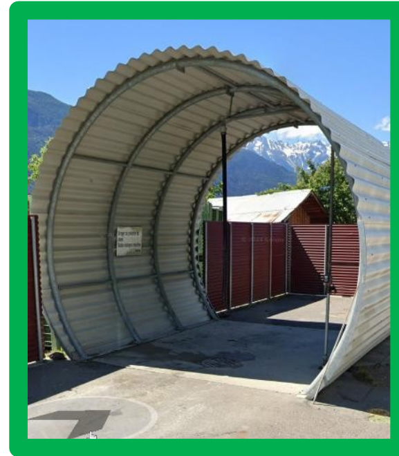
Feste Anlage mit Überlaufauffang
