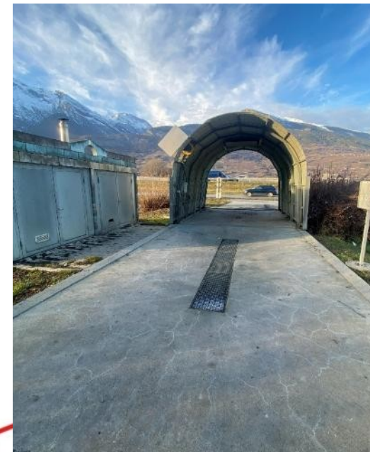
Aire de nettoyage mobile: L'eau de nettoyage est pompée en continu dans la cuve de rétention lors du nettoyage. A cause de l'absence de toit, la bâche doit être rangée après chaque utilisation pour éviter un débordement en cas de fortes précipitations, M. Hochstrasser.
